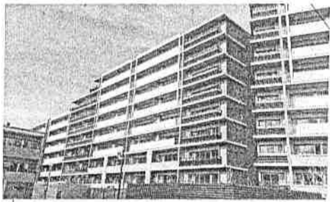
新規の開発が東京都区部など需要の見込める地域に偏りつつある(東京都世田谷区で建設中のマンション)
